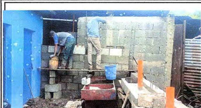
Foto1: reparacion de muro de baño e instalacion de lavamanos de concreto.
