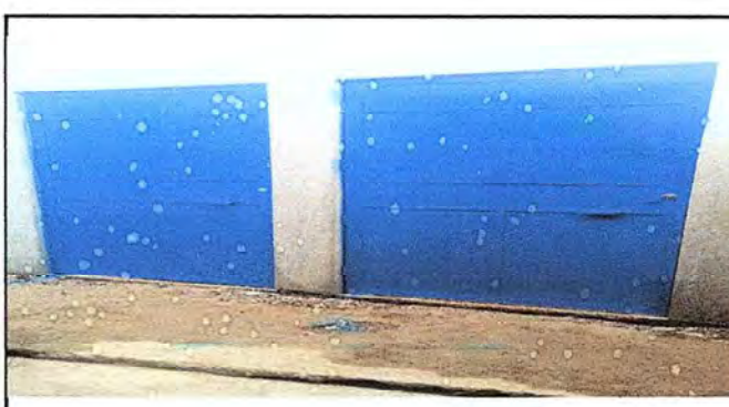
Foto 6: sustitucion de puertas.
