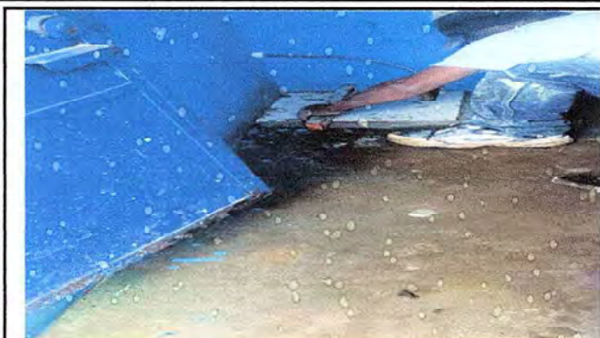
Foto 2: instalacion de piso en los baños
