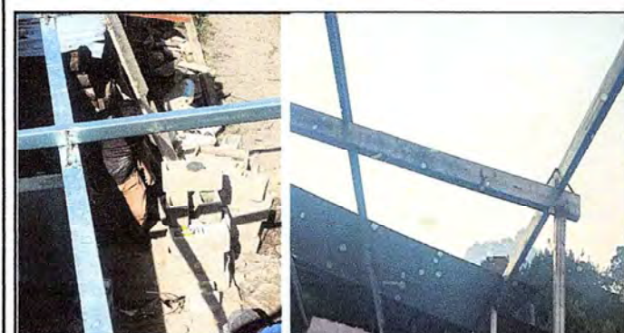
Foto 5: colocacion de tijeras y costaneras para el entechado.
