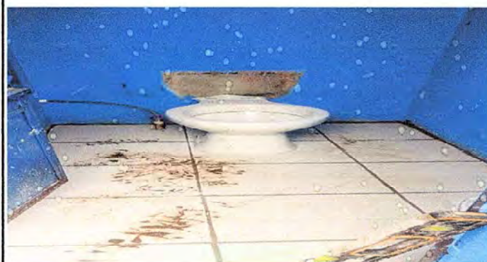
Foto 3: cambio de sanitarios
